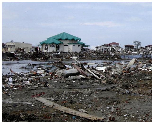
Зруйновані будинки в провінції Ачех (Індонезія) після цунамі 2004 року
